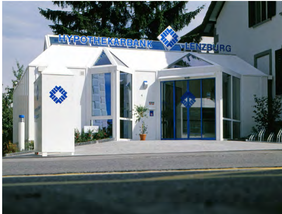
103 Der 1988 erstellte Pavillon Lenzburg West. 2009 wurde er durch einen Neubau ersetzt.
