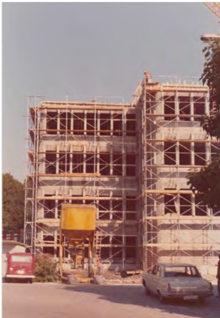
77 Rohbau im August 1973.
