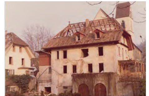
76 Das Mieg-Areal im Oktober 1970 (oben) und während der Abbrucharbeiten im Februar 1971. Im Hintergrund die reformierte Stadtkirche.
