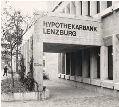
78 Der Autoschalter des Neubaus um 1975.
